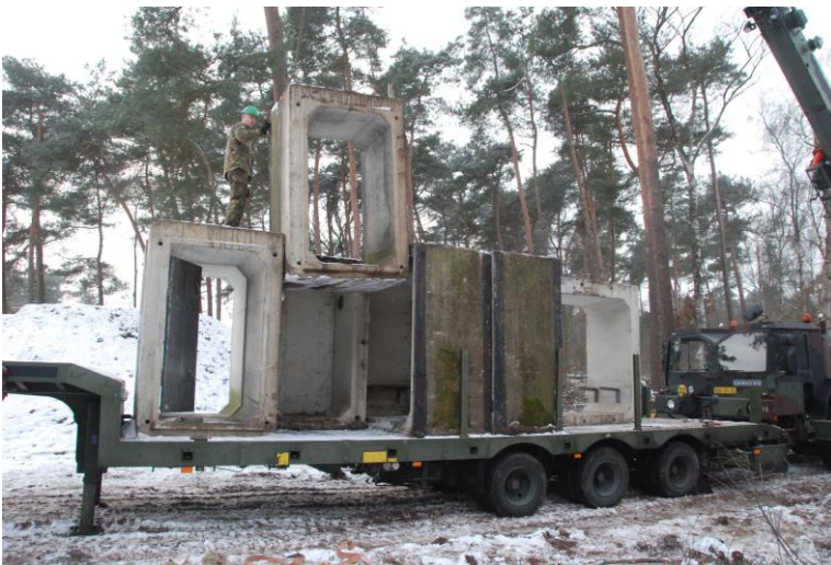
Het plaatsen van één van de nieuwe winterverblijven (foto: Ruud Kaal)
